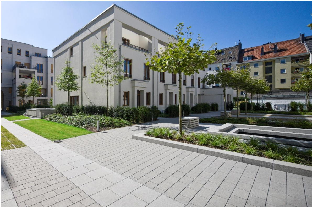
Fachgerecht ausgeführte Betonpflasterfläche.
