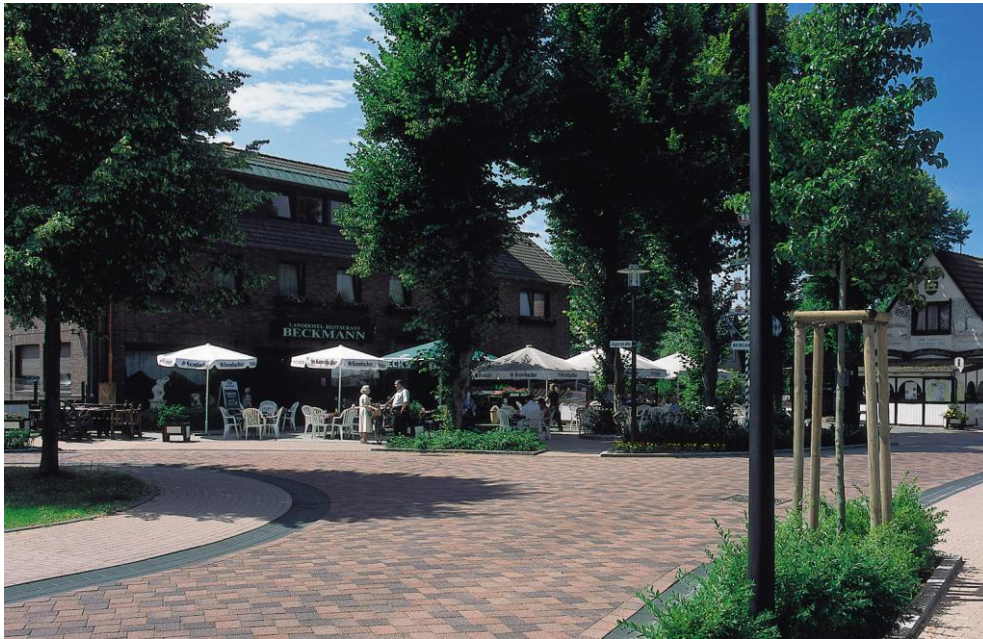
Ein großer Teil kommunaler und privater Verkehrsflächen werden heute mit Pflasterdecken aus Beton befestigt. Foto: BetonBild/SLG
