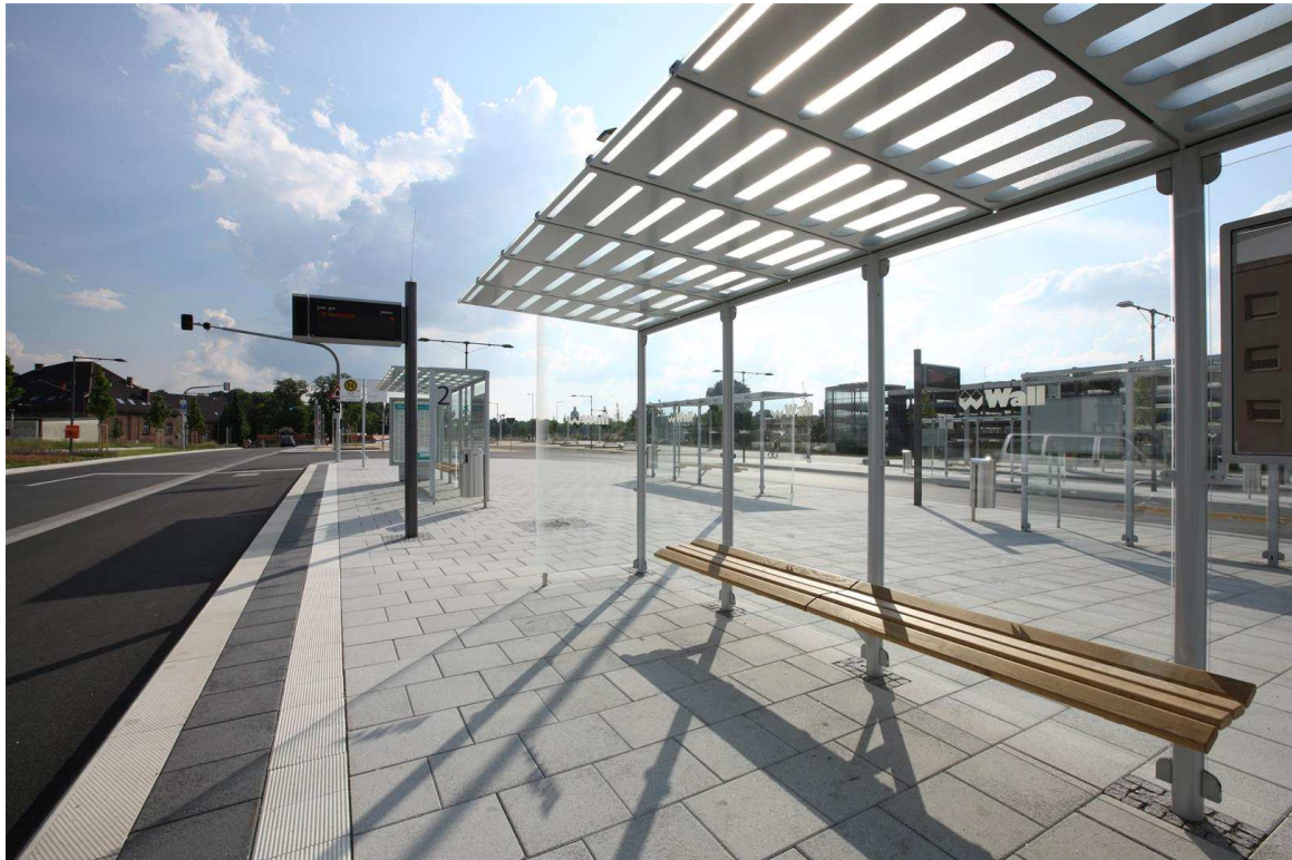
Fachgerechte Ausführung einer Betonpflasterfläche am Neu-Ulmer Busbahnhof.
