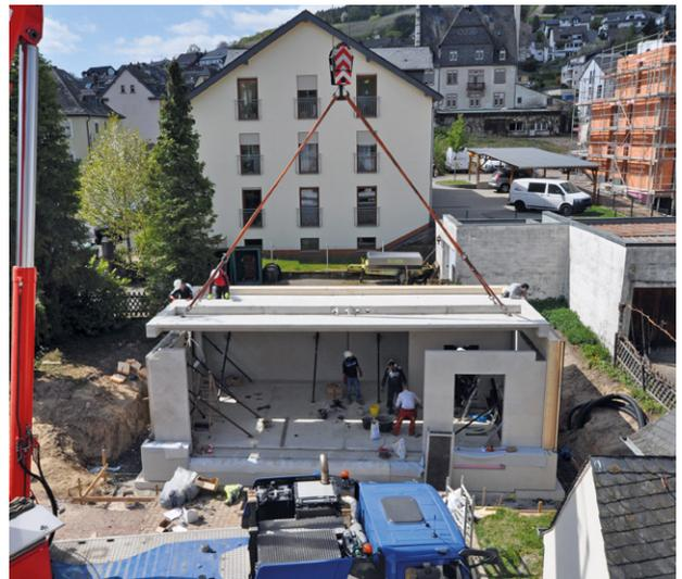
Montage der weitgespannten Deckenplatte für eine Moduleinheit.
