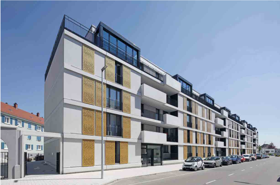
Praxedis-Gärten: Hochwertige, dauerhafte Fassadengestaltung mit Betonfertigteilen.
