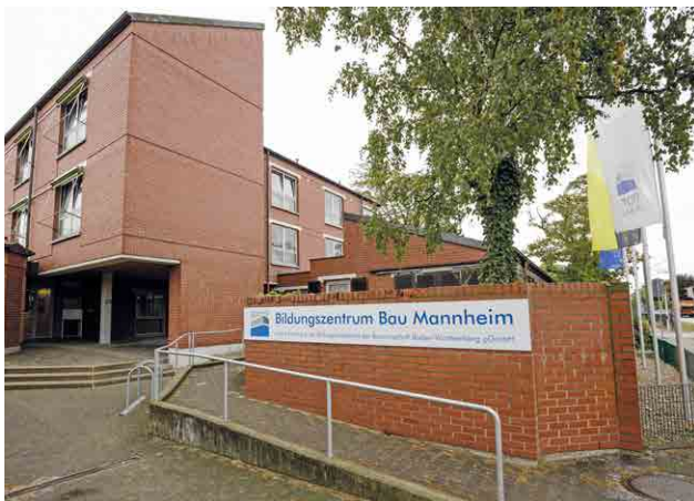
Neuer Standort für die überbetriebliche Ausbildung der Betonfertigteilbauer:innen und Werksteinhersteller:innen – das Bildungszentrum Mannheim.
