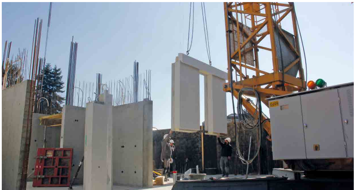
Setzen der Betonfertigteile für die Fassade.
