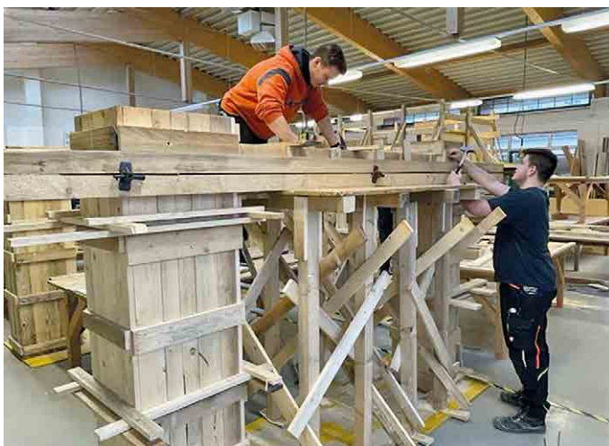
Learning by doing – Bau von Schalungen im zweiten Lehrjahr am ÜAZ in Leipzig.
