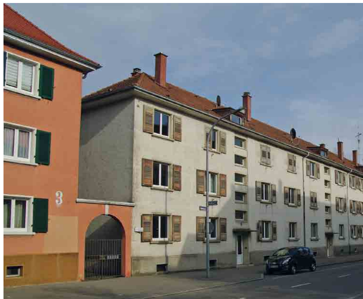
Altes Bestandsgebäude vor dem Abriss.
